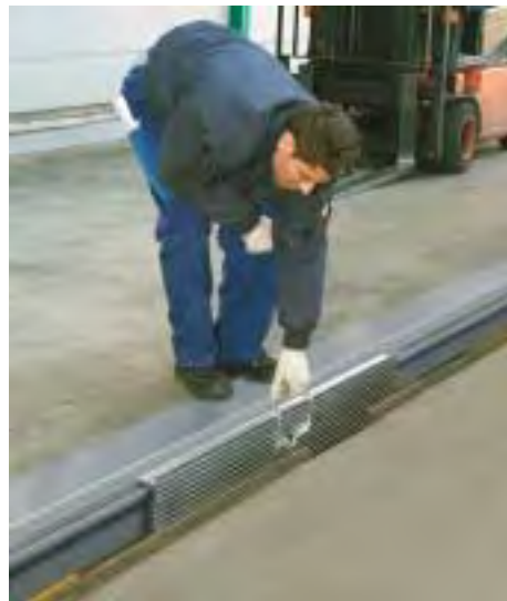
BB-Brücke aus der Führungsschiene herausheben.
